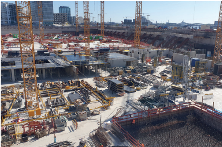
Der Neubau des Überseequartiers in Hamburg, bei dem CEMproof die Abdichtung liefert und verarbeitet
