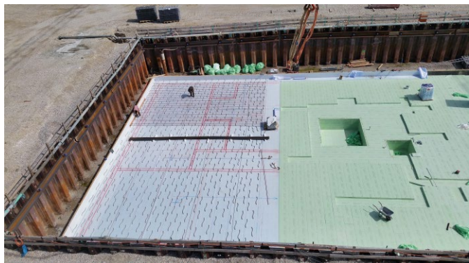
Bild 1 BPA – DualProof als rissüberbrückende Schutzmaßnahme gegen Angriffe durch Kohlenstoffdioxid, Radon- und Methangas
