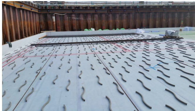
Bild 2 BPA – DualProof als Systemlösung im horizontalen und vertikalen Verbau, auf geneigten Flächen und als Zusatzmaßnahme bei WU-Decken gemäß DAfStb-Richtlinie „weiße Wanne“
