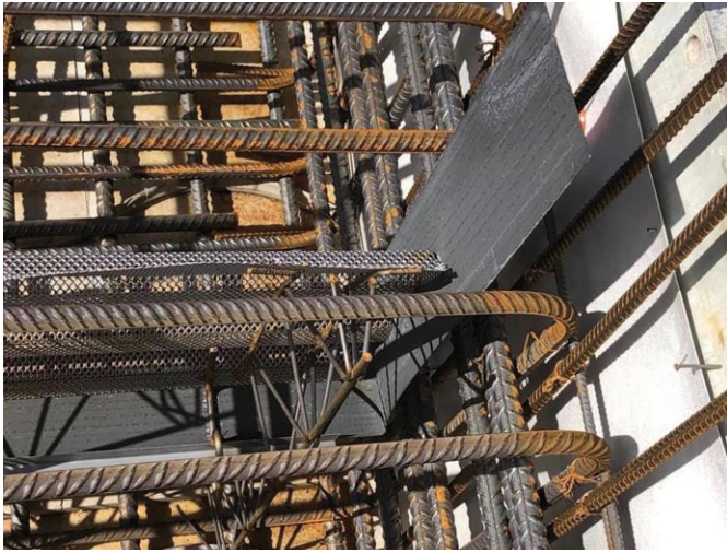
Bild 4 Mineralisch-aktives Fugendichtblech CEMflex® – Systemlösung für alle Arten von Arbeits- und Sollrissfugen
