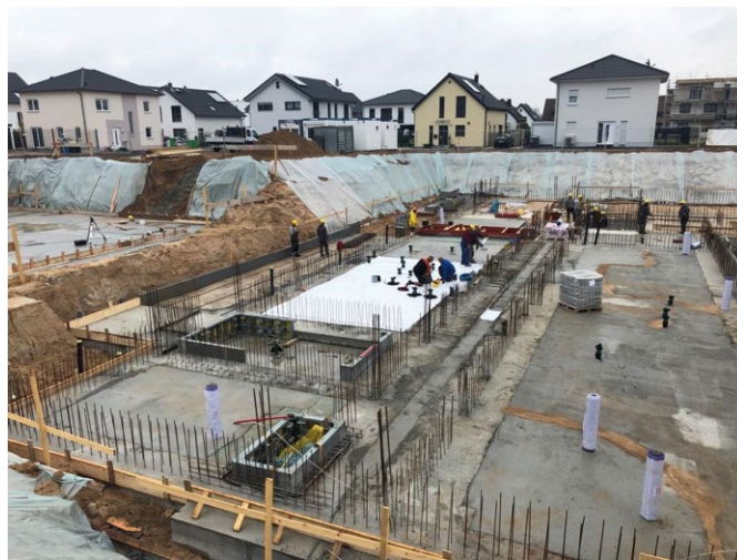
Bild 3 Frischbetonverbundabdichtungs-System BPA - DualProof für „Hochwertige Nutzung von Untergeschossen“ bei drückendem Wasser und chemisch belasteten Grundwässern
