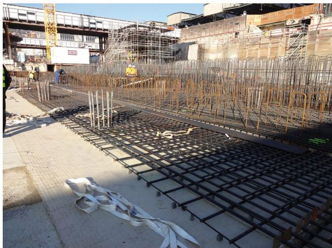
**Bild 3** CEMtobent® CS-Plus FBVS, vollflächig im horizontalen Einbau
