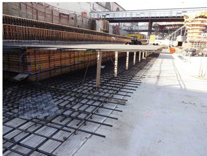
Bild 2 CEMtobent® CS-Plus FBVS, im Bereich der Arbeitsfuge
