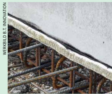
WERKBILD B.T. INNOVATION Neubau und Abdichtung eines Fahrtilos mit Anschlussbewehrung.
