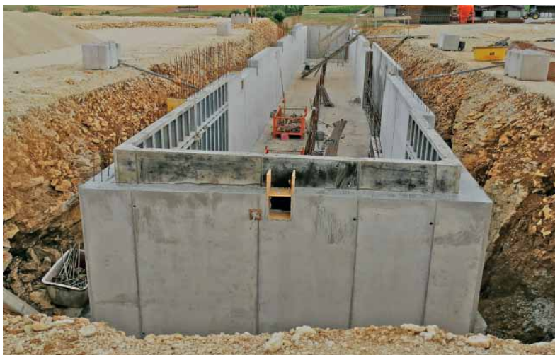
Güllekanal für einen Kuhstall: Bereits erstellte Wände mit mehreren senkrechten Arbeitsfugen. Rechts im mittleren Bereich wird der letzte Wandabschnitt eingeschalt und bewehrt.
