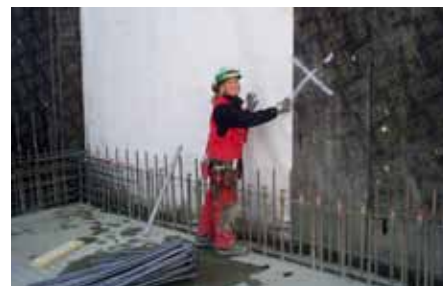
Oben: SilverSeal im Einsatz im Tunnelbau. Unten: Silverseal vorgängig auf Schalung montiert.
