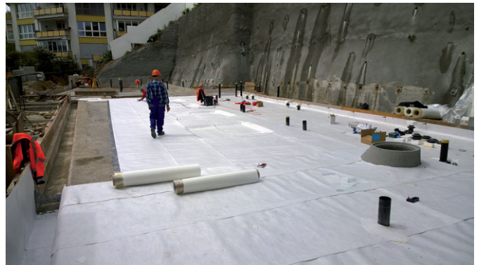
Bild 2 DualProof Bahnenverlegung
