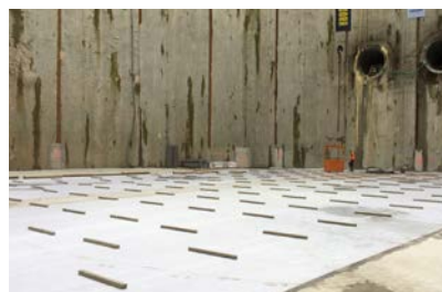
Pumpwerk Oberhausen | Deutschland
