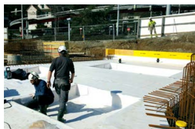
Wohnanlage Bucheggplatz Zürich | Schweiz
