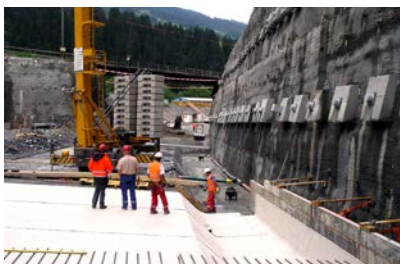
Tunnel Küblis | Schweiz
