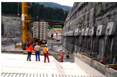
Tunnel Küblis | Schweiz
