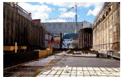
Bahnhof S21 Stuttgart | Deutschland
