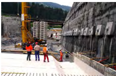
Tunnel Küblis | Schweiz
