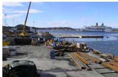
Bjørvikatunnel Oslo | Norwegen
