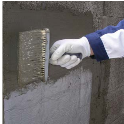
Verarbeitung von BPA-CEMDicht 3 in 1 durch Aufstreichen.
