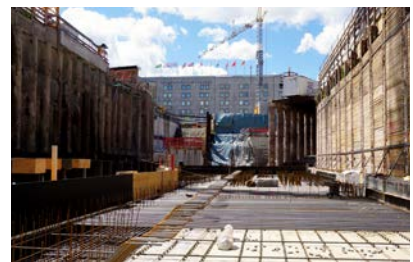
Bahnhof S21 Stuttgart | Deutschland
